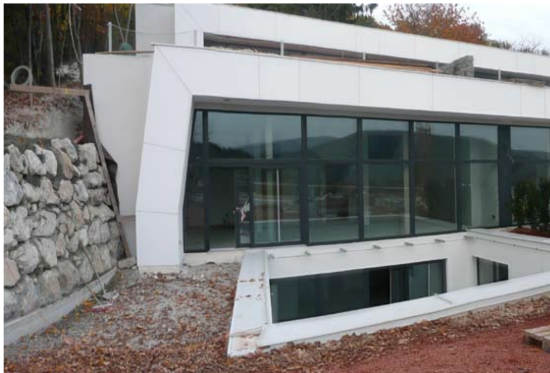
Baustellenfoto 10-2009 Atrium + Fassade
